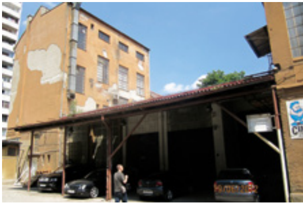
9. Pogled iz dvorišta prema strojarskoj radionici i skladišnoj zgradi (snimila M. Ratkajec, lipanj 2012.). View of the factory from the City of Mainz St. (photo by: M. Ratkajec, June 2012)
