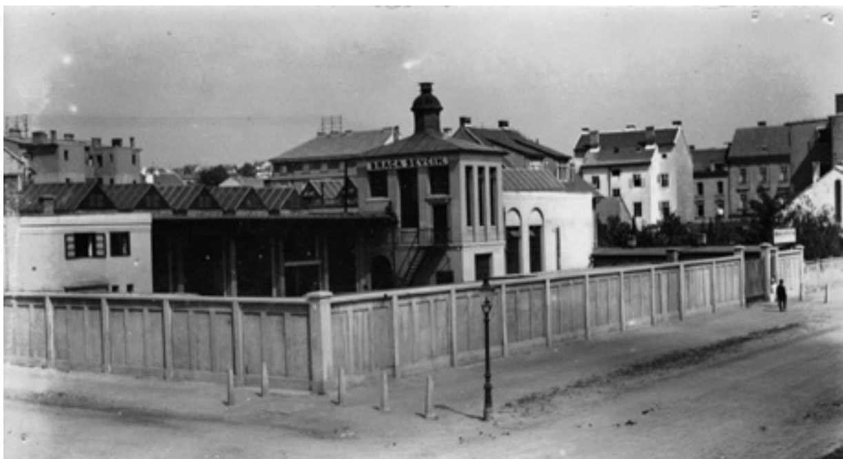
12. Tvornica „Braća Ševčik“ - pogled s jugozapada, fotografija. Izvor: MGZ, Zbirka fotografija, fotografskog pribora i razglednica. The Ševčik Brothers factory – view from the southwest, source: Zagreb City Museum, Collection of Photographs, Photographic Equipment and Postcards
