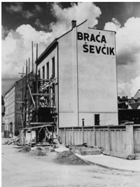
8. Tvornica „Braća Ševčik“ - radionica i ljevaonica, pogled s jugozapada, fotografija. Izvor: MGZ, Zbirka fotografija, fotografskog pribora i razglednica.
