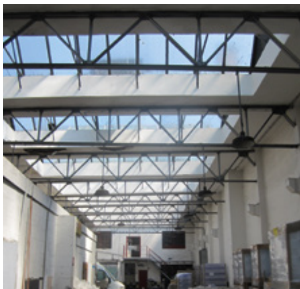
17. Radionica za montiranje željeznih konstrukcija - pogled s juga (snimila M. Ratkajec, lipanj 2012.).
