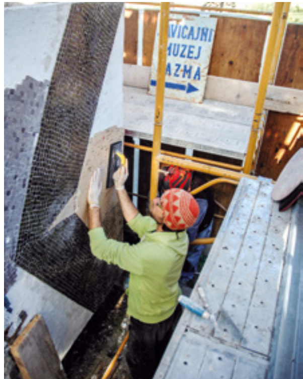
14. Lijepljenje mozaika na zidove u segmentima, tijekom radova 2012. (snimio T. Šaina, Arhiv HRZ-a).
