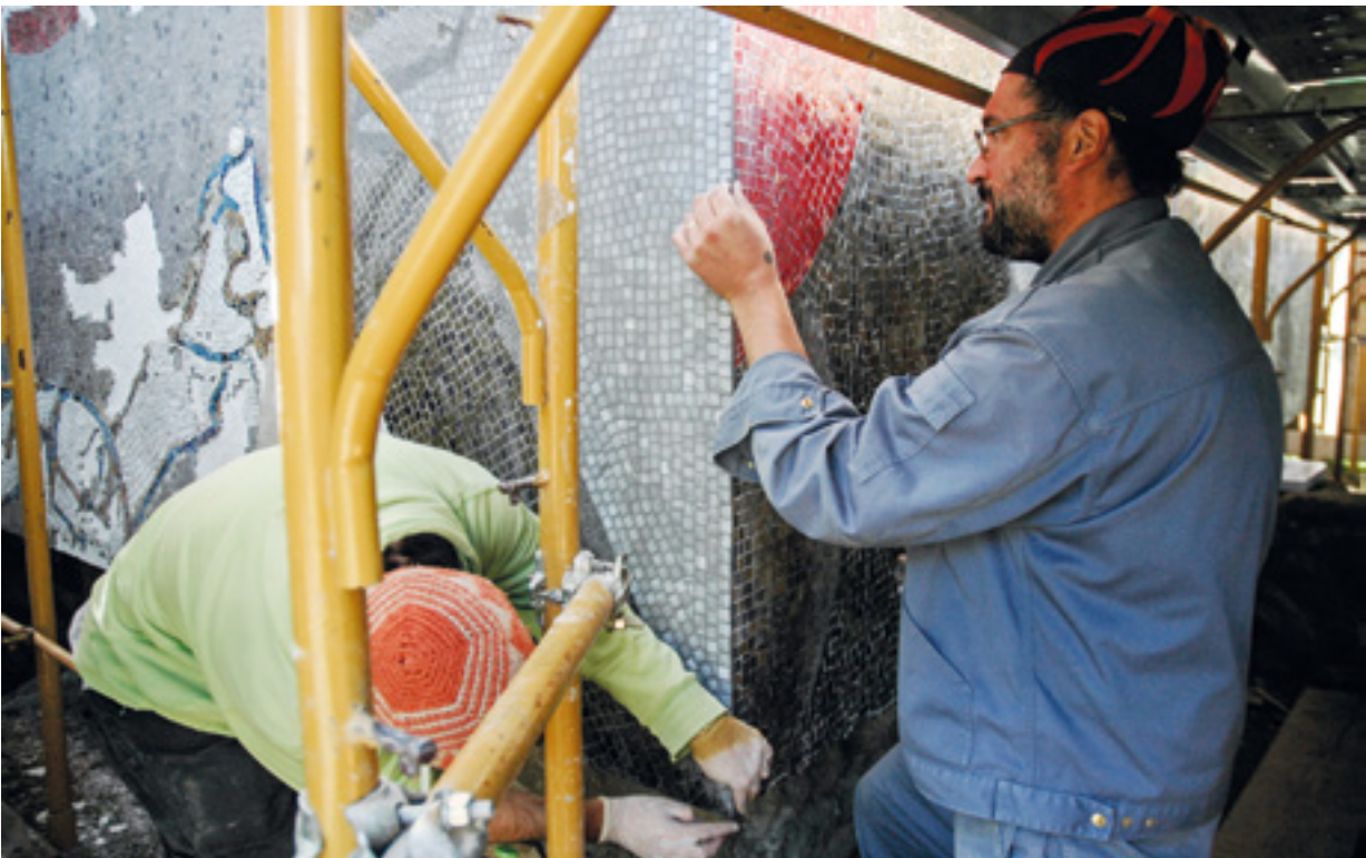
15. Završno namještanje i fugiranje mozaika nakon montaže, tijekom radova 2012. (snimio T. Šaina, Arhiv HRZ-a).
