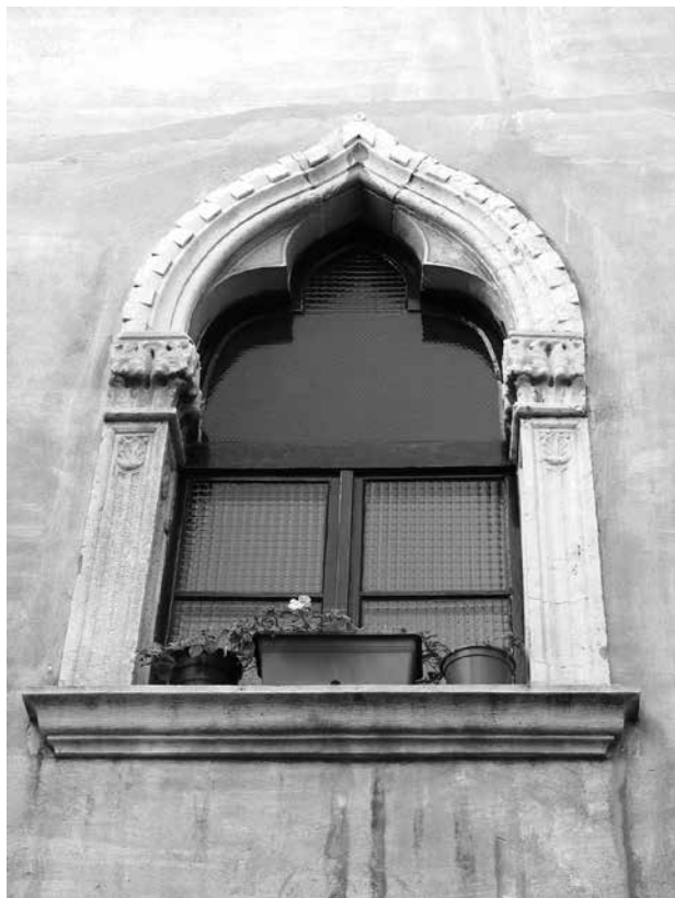
Prozor ugrađen u dvorišnu fasadu kuće Fanfogna u Zadru (foto: L. Borić) / Court facade window of the Fanfogna house in Zadar
