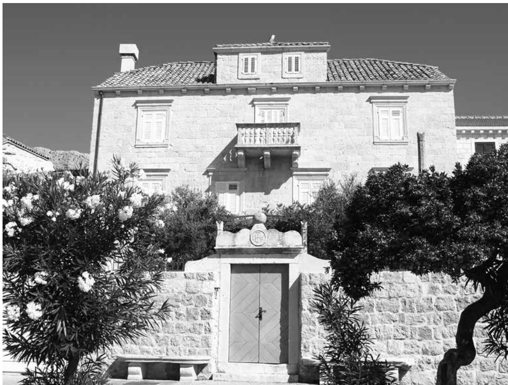
12. Kuća Župa građena 1797. godine / Župa house built in 1797
