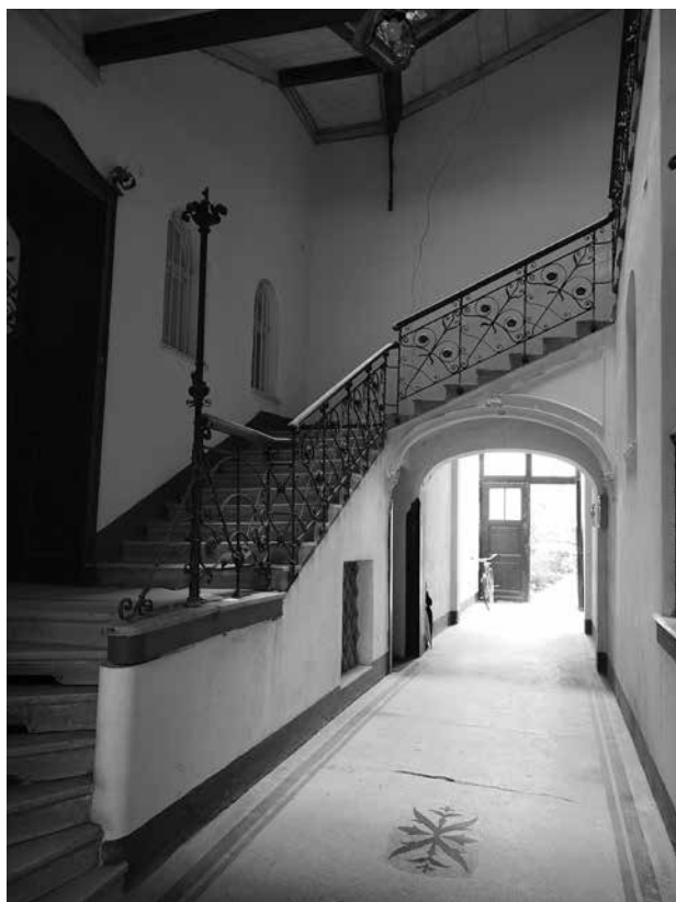
Stubište zgrade u Žerjavićevoj 4 (foto: D. Damjanović, 15. 7. 2013.) / Staircase of the building in 4 Žerjavića street
