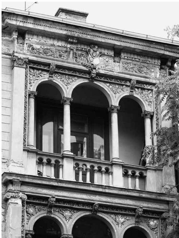
Detalj raščlambe lođe drugoga kata, današnje stanje (foto: D. Damjanović, 15. 7. 2013.) / Detail of the loggia on the 2nd floor, present condition
