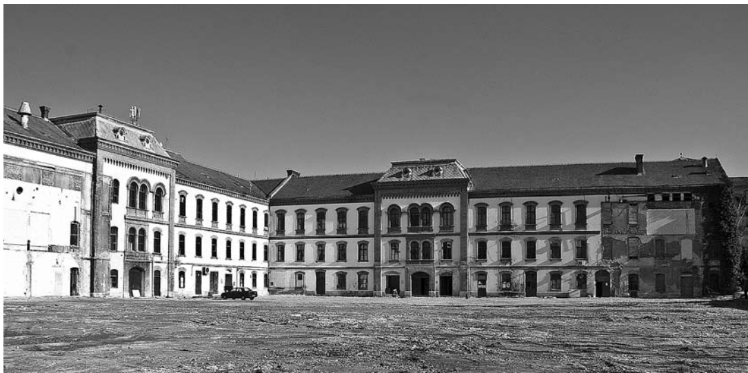
sl.2. Pogled na zgradu iz Jagičeve ulice nakon rušenja nadogradnje Tvornice duhana iz 1971.
