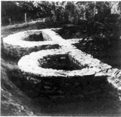
5 Bazeni rimskog kupališta nakon konzervacije 5 The pools of the bath resort after the conservation
