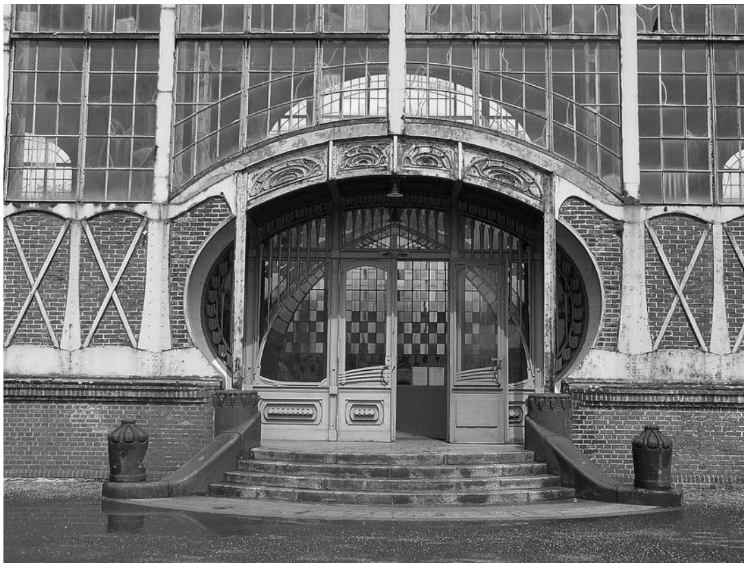
sl. 38. - 40. Kada su građene na prijelazu iz 19. u 20. stoljeće, zgrade rudnika Zeche Zollern trebale su pokazati uspješnost kompanije koja je bila njihov vlasnik. Danas se u tim biserima secesijske arhitekture nalazi sklop Westfalijskog industrijskog muzeja u Dortmundu.
