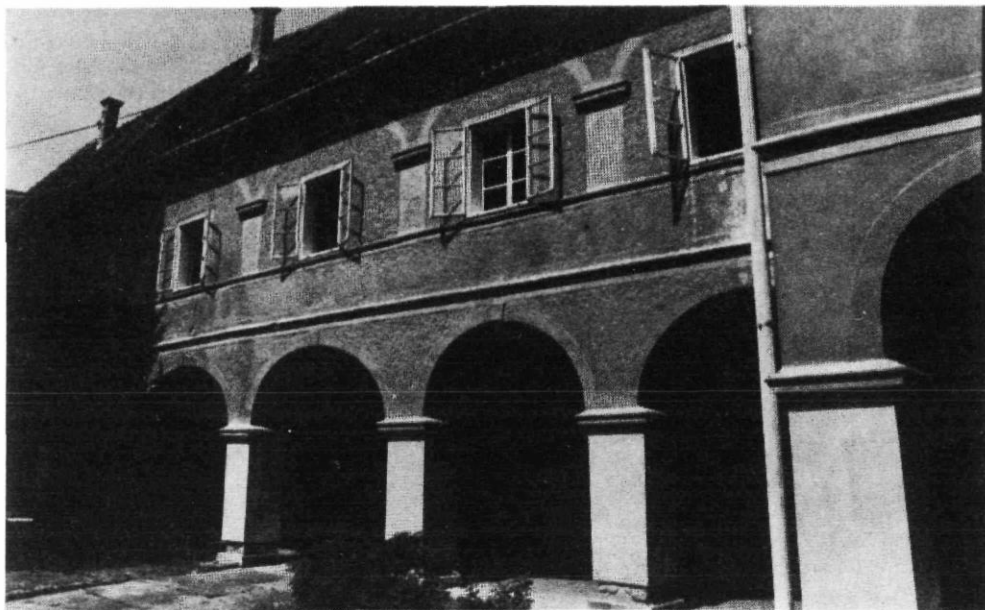
Slika 2. – Dvorišno pročelje sjevernog krila dvorca.
