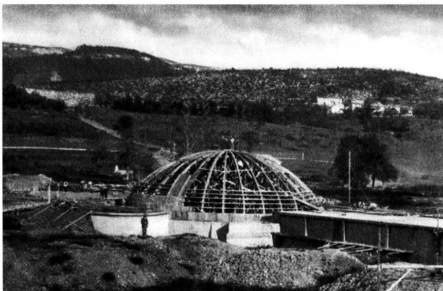
Acquedotto del Quieto. Opere di presa durante i lavori
