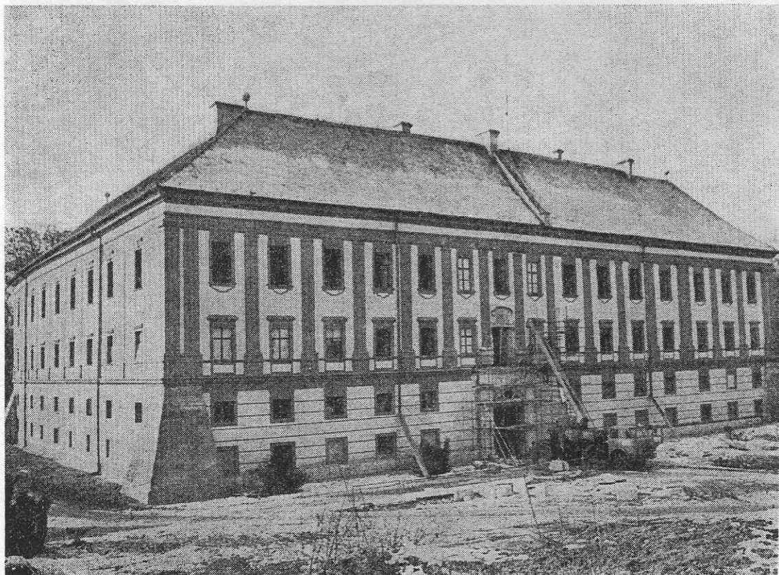
Sl. 2 — Pročelje pri završetku rekonstrukcije (foto: Ž. Hlebec)
