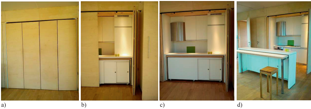
Slika 3. Kuhinja u različitim fazama otvorenosti (a – zatvorena, b – poluotvorena, c – otvorena, sa spremljenim kuhinjskim otokom, d – otvorena, s izvučenim kuhinjskim otokom) (Foto: Novak, M., 2014.)
