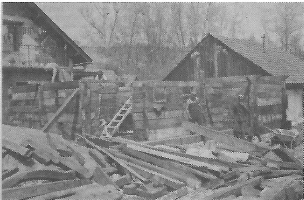
Rekonstrukcija objekta kbr. 51 S
