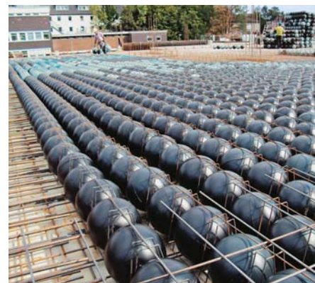
SLIKA 5 – Puhane plastične kugle za stvaranje šupljina u betonskim podnim konstrukcijama
