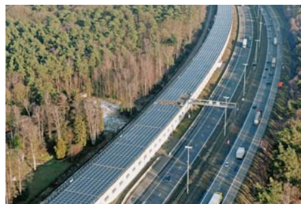
SLIKA 4 – Solarni paneli nad željezničkom prugom u Belgiji
