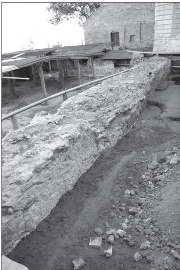
Sl. 3. Južni zid sjevernog krila dvorca Fig. 3. South wall of the north castle wing
