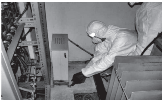
Slika 1. Zaštitna sredstva koja se upotrebljavaju pri demontaži kondenzatora s PCB-om
