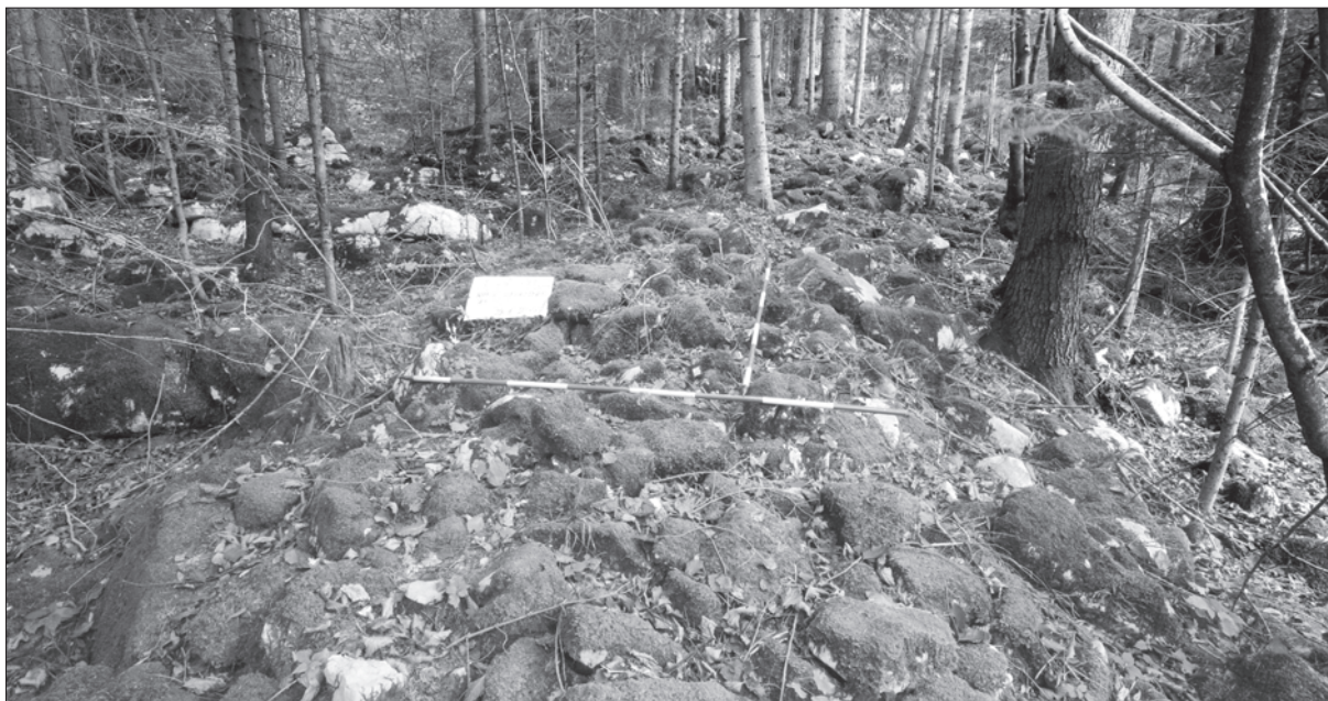
Sl. 2. Prezid 2006. g. – struktura rimskoga obrambenog zida na odsjeku trase u podnožju Vražjeg vrteca (foto: D. Pelić)
