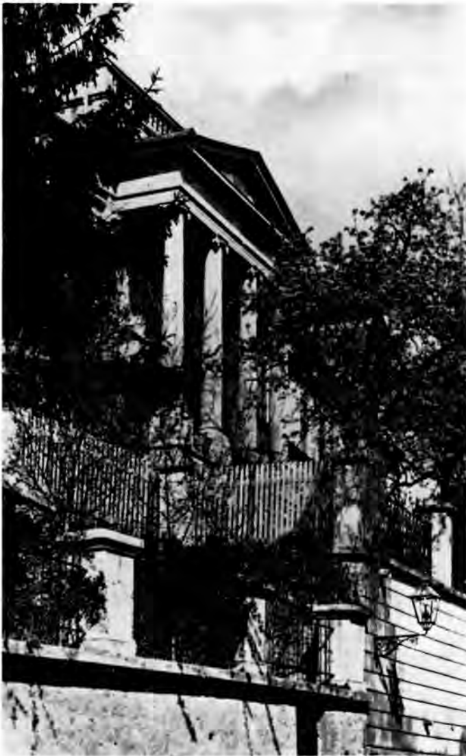
6 ALEKSANDAR BRDARIĆ: Palača Ane Paravić, rođ. Vojkffy, izgrađena kao jednokatnica god. 1839. Naknadno nadograđena drugim katom. Pogled na palaču iz gornjeg dijela Duge ulice. Ispred starije kuće koja je ranije stajala na mjestu palače vrt je bio zasnovan već god. 1810. Razglednica izdana nakladom Josipa Čaklovića.
