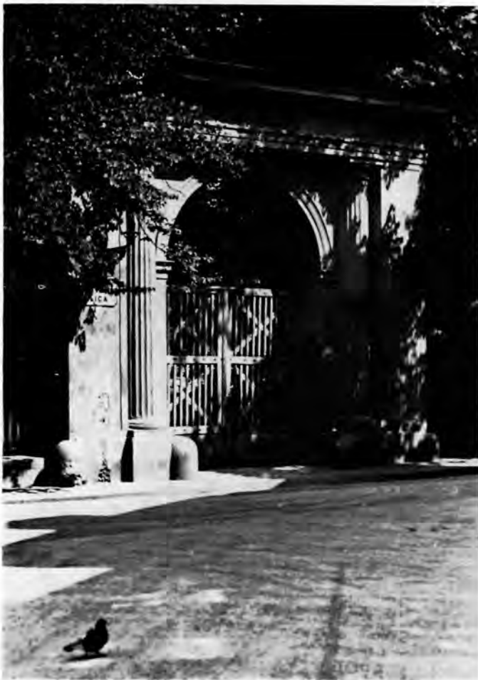
3 BARTOL FELBINGER: Ulazni portal u sastavu ograde vrta palače Magdalenić-Drašković u Demetrovoj ulici u Zagrebu, izgrađen oko godine 1830.
