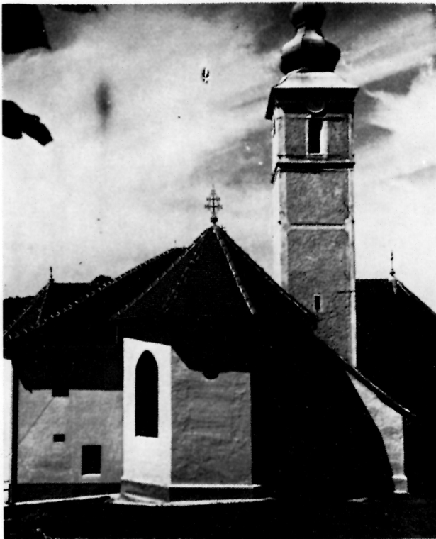
8 Mihovljan kod Zlatara, gotička, barokizirana, župna crkva 30. VII. 1940. srušena u ratu 1943, foto Đuro Griesbach
