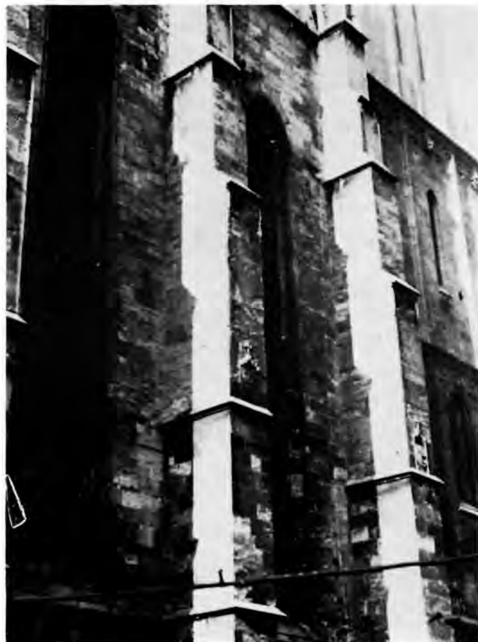
26 Detalj sjevernog pročelja lađe.
