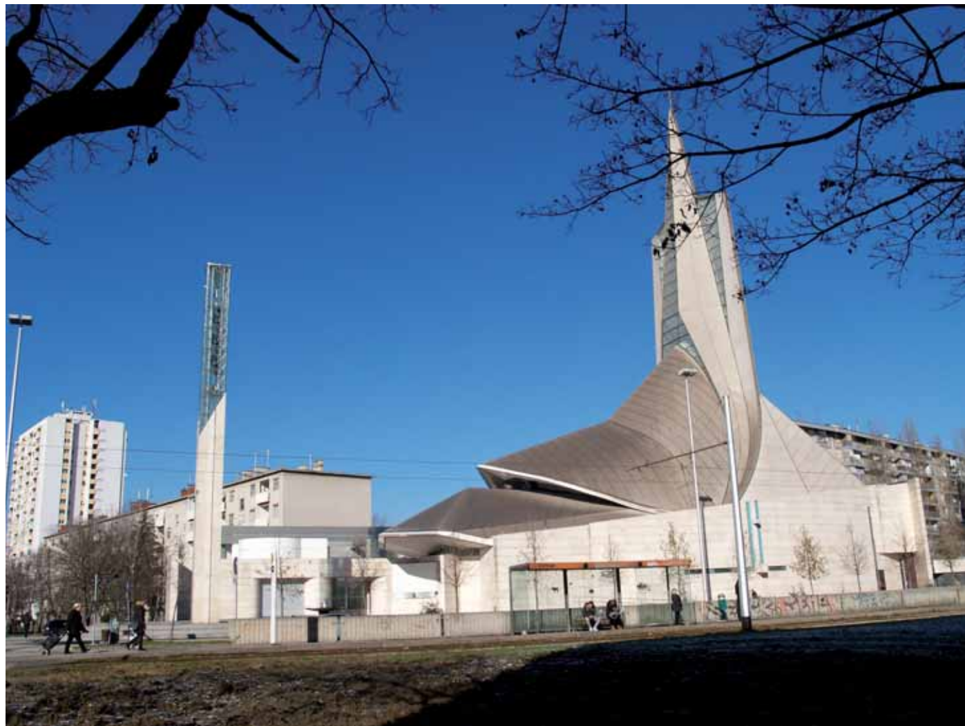
Crkva Blaženog Augustina Kažotića u Zagrebu, 1998.-2013. južno pročelje
