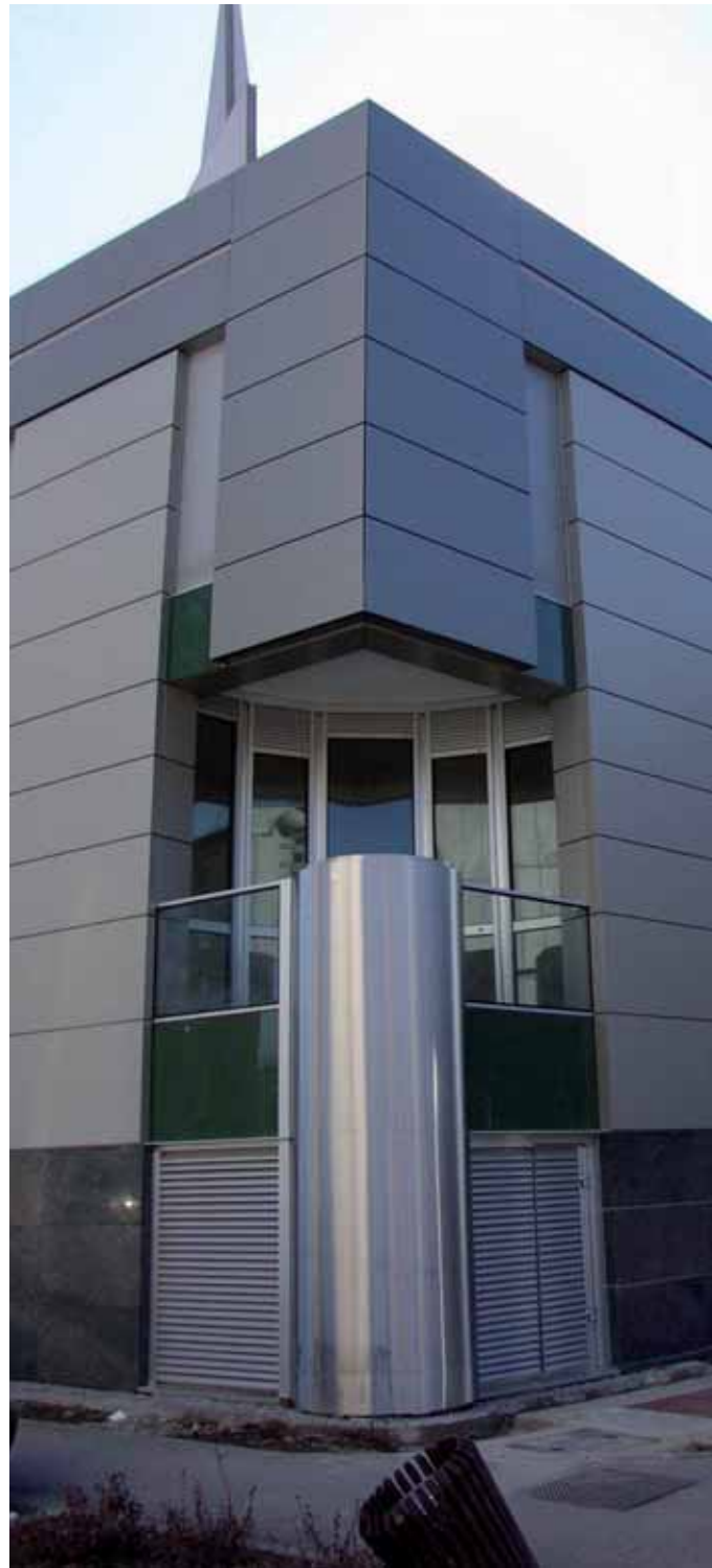
Crkva Blaženog Augustina Kažotića u Zagrebu, 1998.-2013. detalj pročelja
