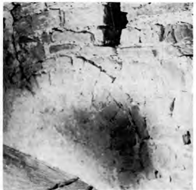
19 Naslon greda stropa iznad sredine prozora na južnoj strani srednje dvorane.
