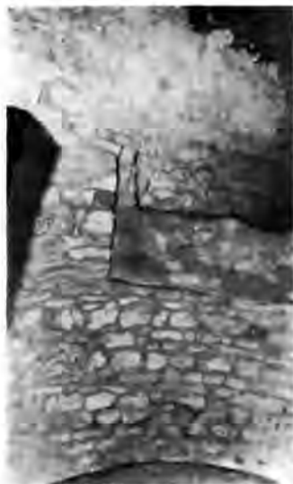
9 Ostaci zida prozorčića na zidu zapadne apside u prizemlju biskupskog dvora.
