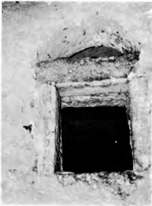
1 Istočna strana prozora u prizemlju na pregradnom zidu koji je dijelio srednju od istočne prostorije biskupskog dvora građevnog sklopa Eufrazijeve bazilike u Poreču.
