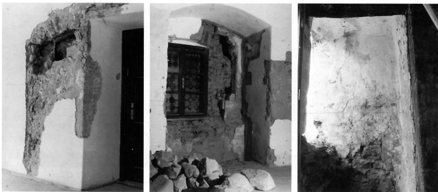
21. Sonda s otvorom između kuhinje i blagovaonice na prvome katu. 23. Zapadni prozor u sjevernom zidu kata s otkrivenim dijelovima izvornoga prozorskoga okvira. 24. Palas, zahod u sjeverozapadnom zidu drugoga kata.
