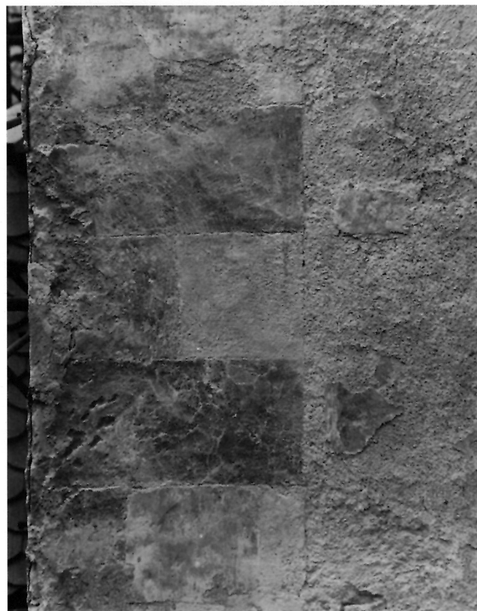
13. Palas, jugoistočni ugaon, oslikani ugaoni kvadri izvornog pročelja palasa Prva građevinska mjena).
