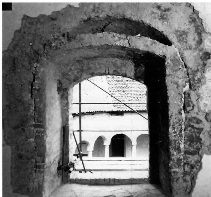
30. Palas, nadograđeni treći kat, pogled iznutra na žitni otvor. Jasnno se uočavaju obje mjene ovog otvora.
