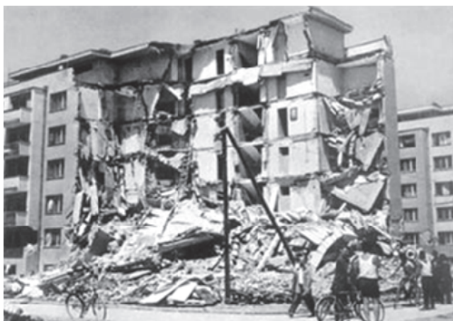
Slika 1. Teško oštećena stambena zidana zgrada (pet katova) [3]
