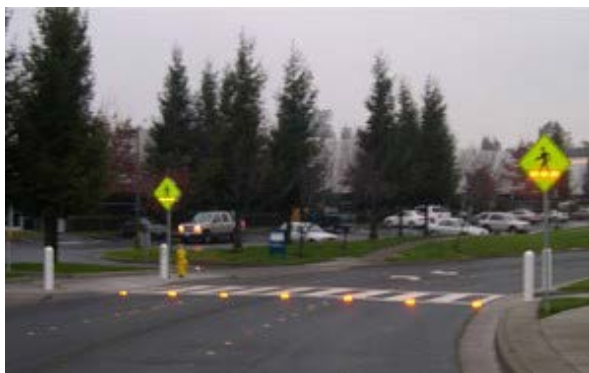
Slika 4. Obilježavanje pješačkog prijelaza LED prometnim svjetlima
