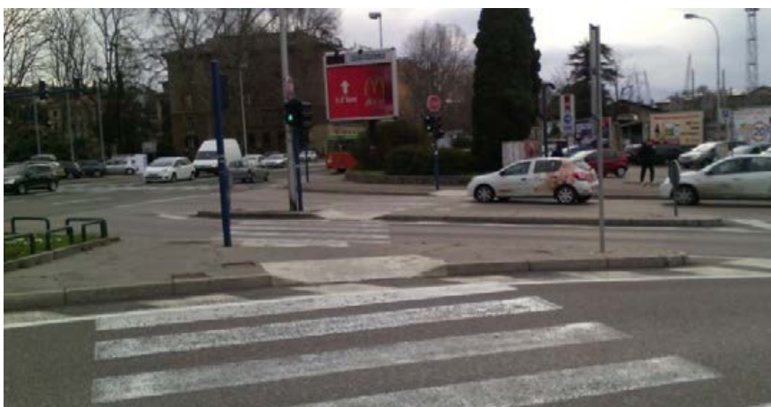
Slika 2. Pješački prijelaz s uređenim pješačkim otokom
