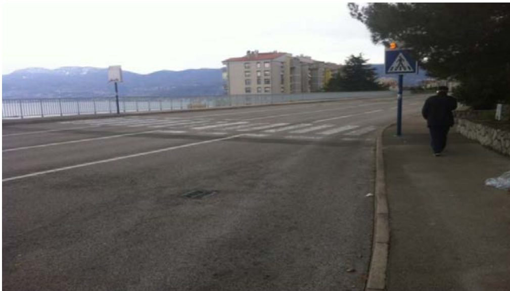
Slika 3. Pješački prijelaz bez uređenog pješačkog otoka
