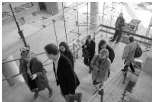
sl. 2. i 3. Obilazak nove zgrade MSU u izgradnji, 17. listopada 2005.
