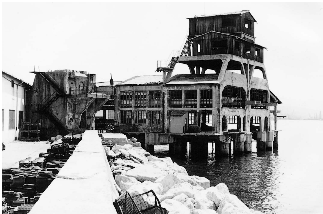
sl.2 Pogled na građevinu lansirne rampe za ispitivanje torpeda u Rijeci. Rampa je sagrađena između dva svjetska rata, na mjestu ranijih lansirnih uređaja iz 1900-tih i 1880-tih godina. Sva torpeda su se prije isporuke probno lansirala.
