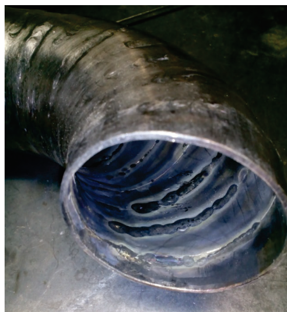
Slika 18. Unutrašnjost cijevi zavarena korištenjem naprave za zaštitu korijenskog zvara
