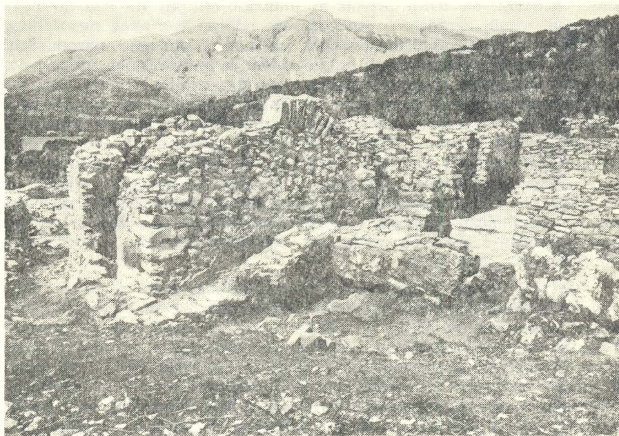
Cisterna s južne strane (foto K. Tadić)
