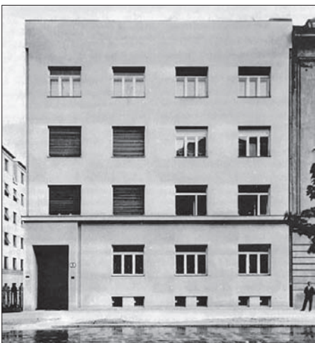
SL. 5. TROKATNA UGRADENA NAJAMNA STAMBENA KUĆA DEUTSCH, VUKOTINOVICEVA 5 U ZAGREBU, HR, 1929.-1931., SAGRAĐILO GRAĐEVNO PODUZEĆE GRAĐ.INŽ. LEO NEUBERGER
