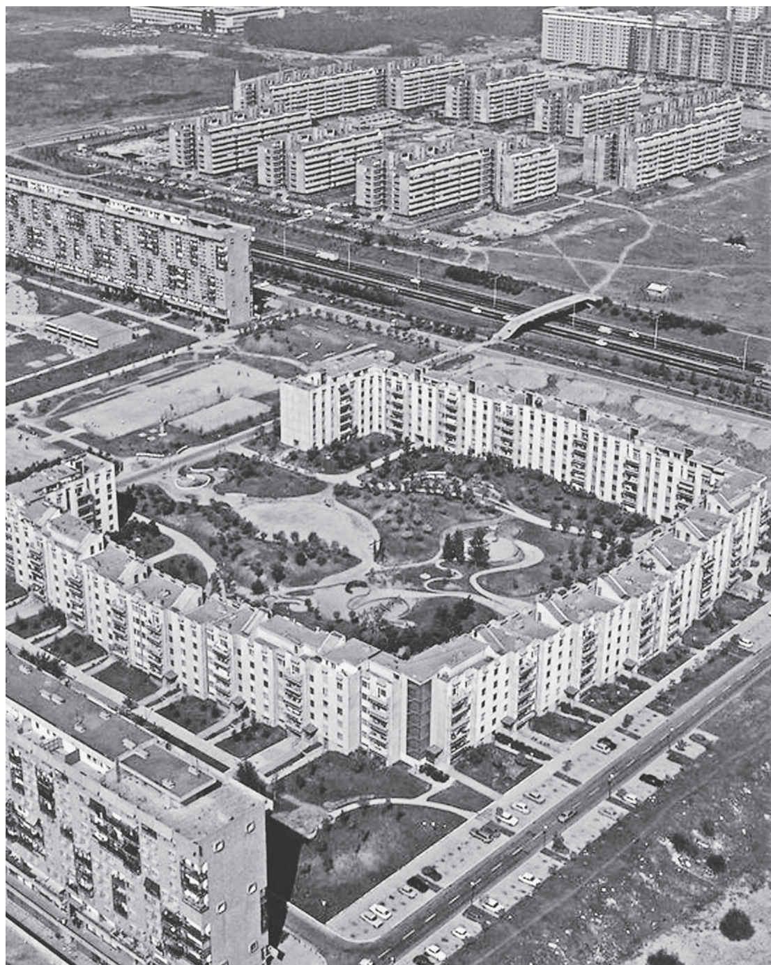
SL. 1. FOTOGRAFIJA ZGRADE 'POTKOVIČA', BLOK 28, IZ ZRAKA FIG. 1. 'HORSESHOE' BUILDING, BLOCK 28, AERIAL PHOTO
