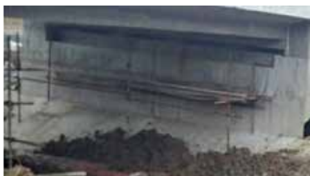
Slika 4. Izrada novih ležajnih greda
