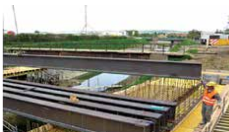
Slika 5. Montaža i izrada raspanske konstrukcije
