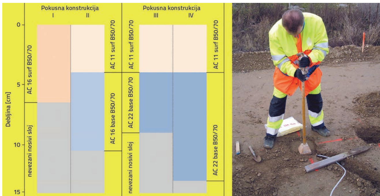
Slika 3. Ispitane kolničke konstrukcije (lijevo), postavljanje senzora u nosivi sloj (desno)
