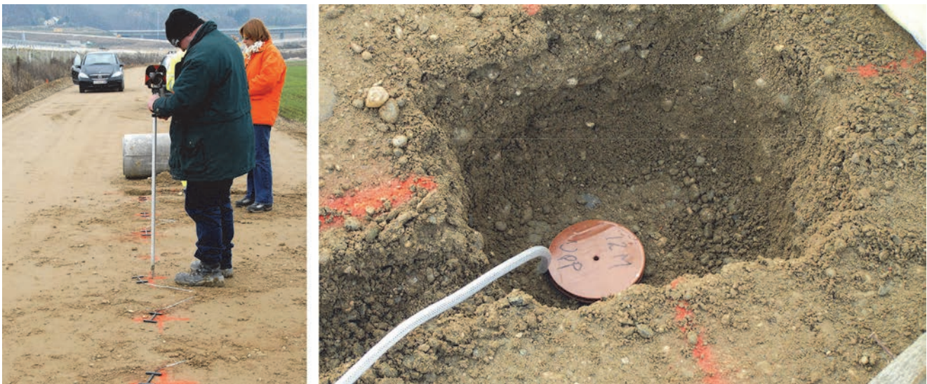
Slika 4. Mjerači deformacija asfalta (ASG) i indukcijske zavojnice (EMU)
