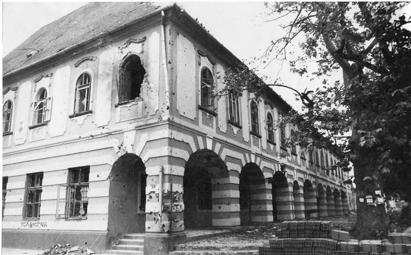
Gradski muzej Vinkovci – izravnim pogotkom granate probijeno je pročelje i oštećena unutrašnjost muzeja 17. 9. 1991. Snimio: Antun Smajić
