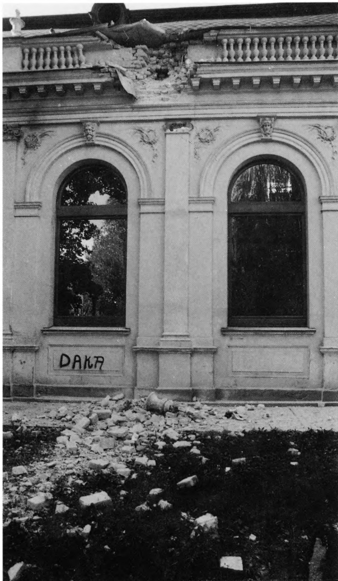
Spomen muzej II. kongresa KPJ, Vukovar Zgrada Radničkog doma, u kojem je smješten muzej, oštećena je prilikom bombardiranja grada 25. i 26. 8. 1991. Snimila: Ruža Marić
