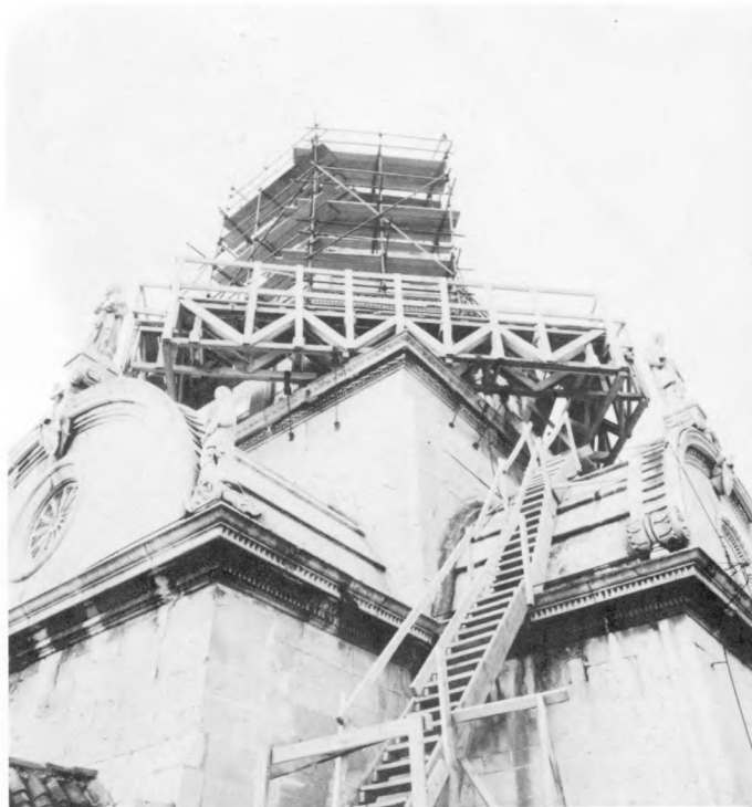
Šibenik, zaštitni radovi na oštećenoj kupoli katedrale Snimio: Damir Fabijanić
