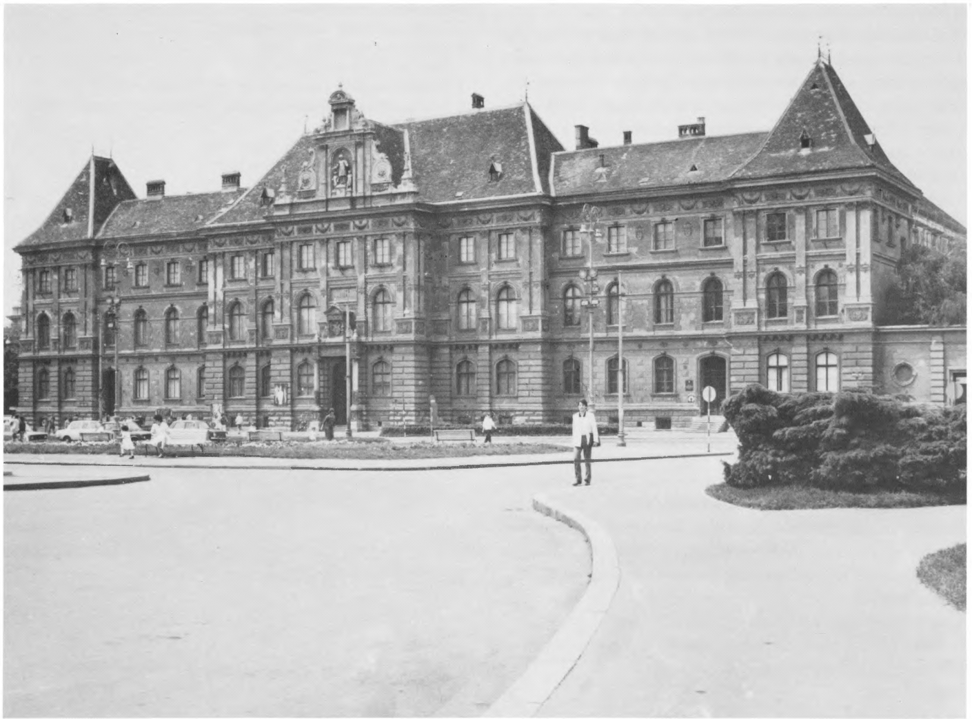
Muzej za umjetnost i obrt, Zagreb – pročelje i detalj prije obnove; snimio: Marijan Kumpar
