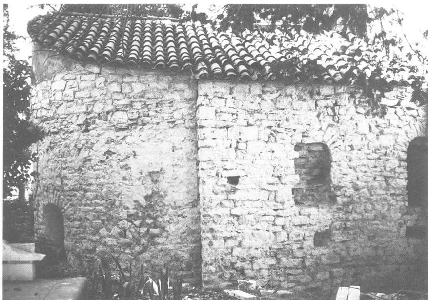
Sjeverni zid ranokršćanske crkve i apsida s izvornim prozorima
