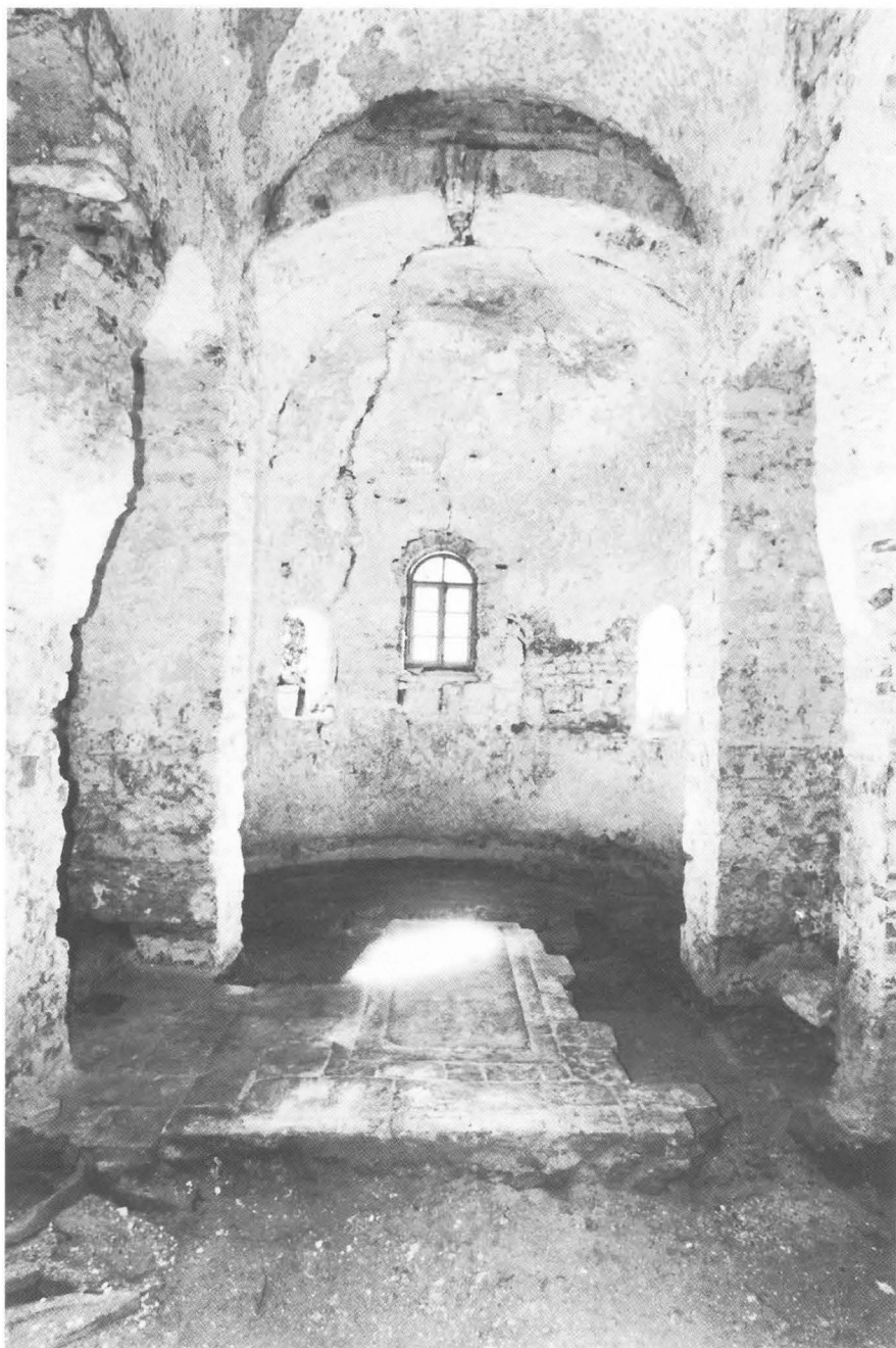
Pogled na svetišče crkve s dodanim srednjovekovnim pilastrima i svodom
