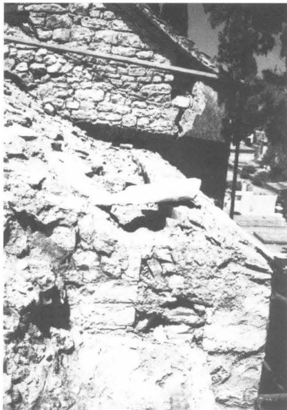
Tragovi prividne trobrodnosti pučiške crkve na spojevima kasnoantičkih vanjskih zidova i umetnute ranosrednjovjekovne svodene konstrukcije
