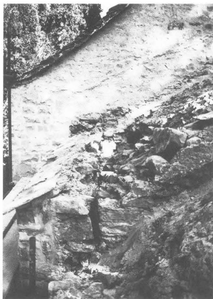
Tragovi prividne trobrodnosti pučiške crkve na spojevima kasnoantičkih vanjskih zidova i umetnute ranosrednjovjekovne svodene konstrukcije
