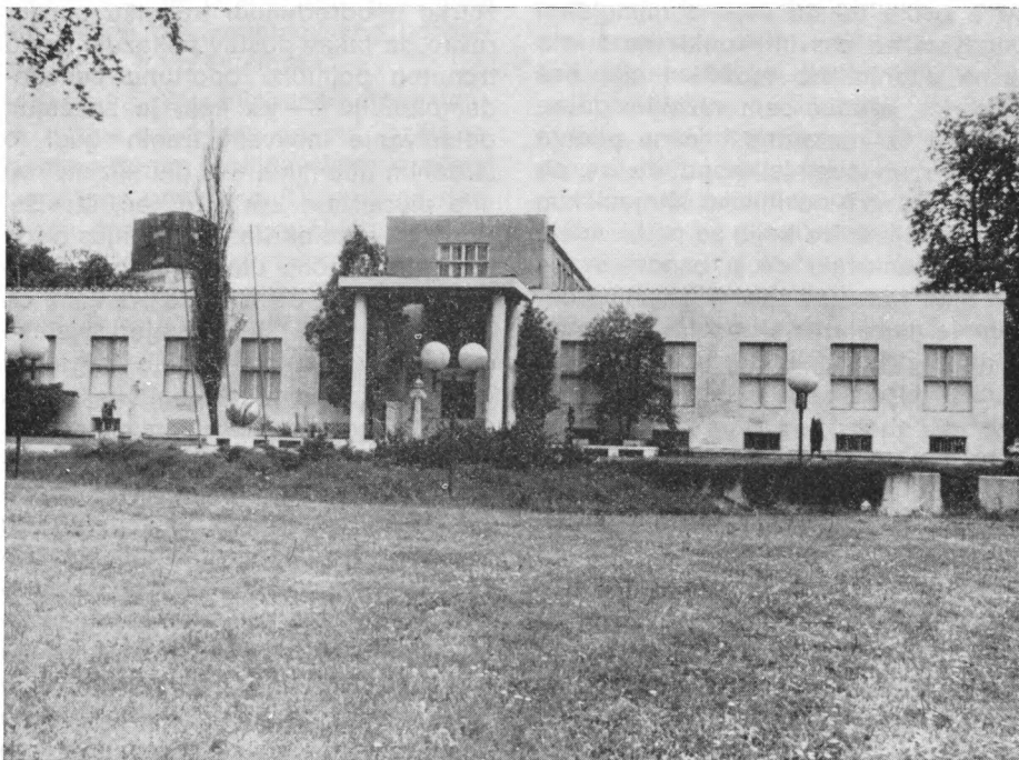
Zgrada Moderne galerije u Ljubljani
