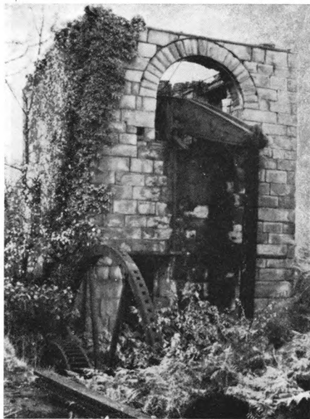
Napušteno industrijsko postrojenje, Wales
