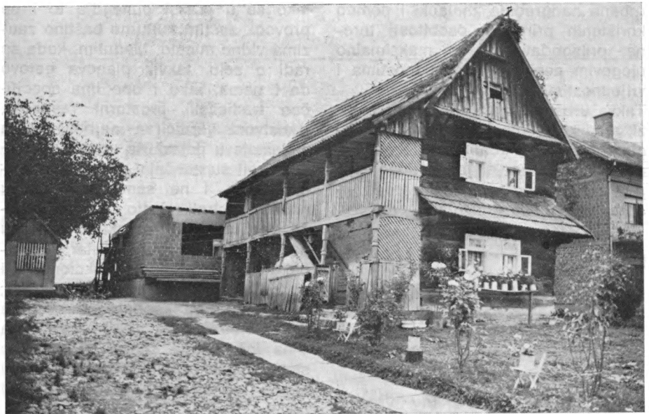
Kutinsko Selo — Kutina ul. Radićeva 108. Učestala pojava Novogradnja napravljena iza kuće prouzročit će rušenje starog čardaka. Foto: Igor Nikolić
