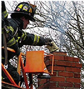
Slika 9: Bombe za gašenje požara dimnjaka
