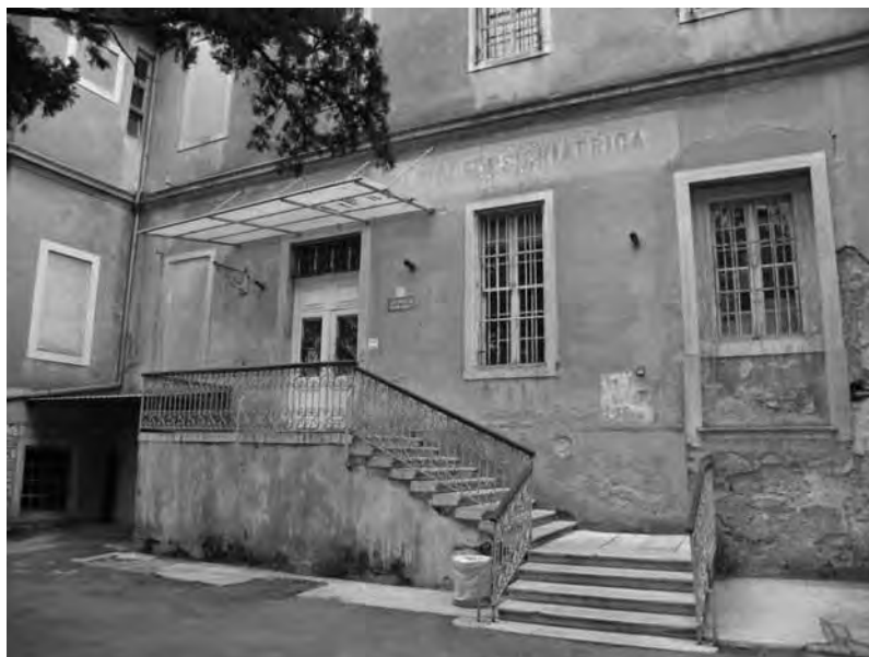
L'entrata alla sezione psichiatrica oggi con ancora ben visibile la vecchia scritta sulla facciata.
