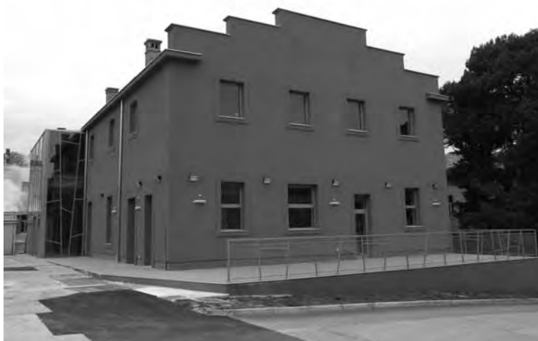
L'edificio della lavanderia e della cucina oggi completamente risistemato per le necessità del campus universitario.
