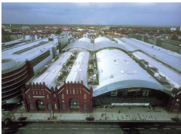
Slika 2. Obnovljeni industrijski kompleks Am Borsigturm u Berlinu
