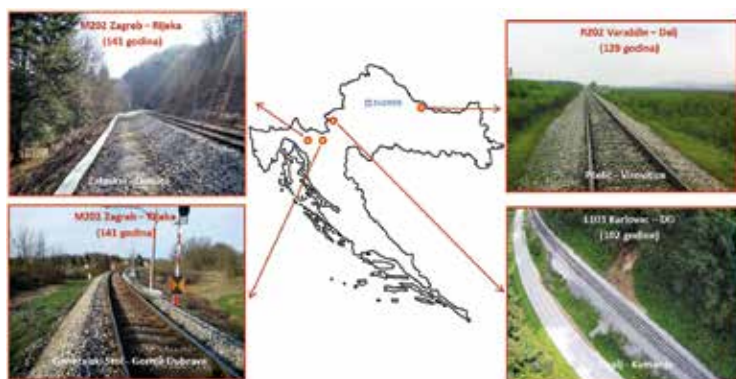
Slika 1. Primjeri nestabilnih željezničkih nasipa u čijoj je sanaciji sudjelovao Zavod za geotehniku pri Građevinskom fakultetu u Zagrebu
