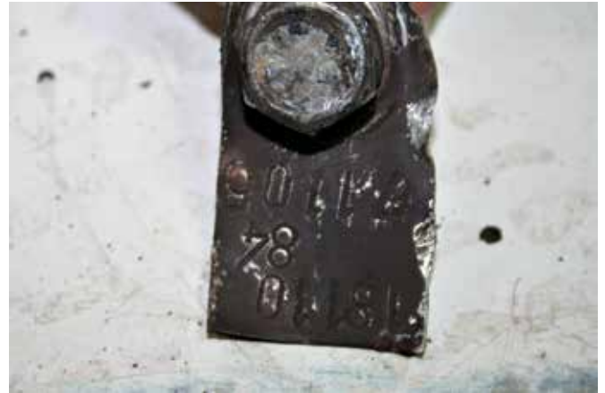
Slika 7: Pločica s oznakama oštećenog ležaja
