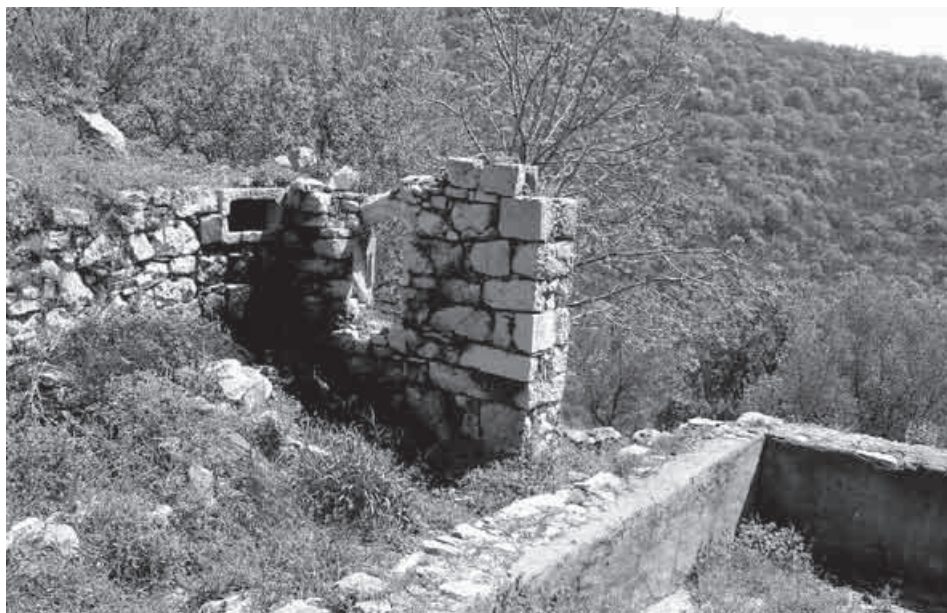
Slika 60. Primjer devastacije - kamenica ugrađena u zid pomoćnog ruševnog objekta. Izvor: Fototeka Konzervatorsko odjela u Rijeci.
