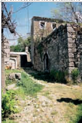
Vanjsko zide s ulaznim otvorom Izvor: fototeka KOR, 2001.
