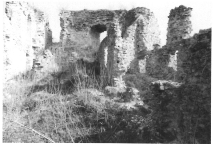
14. Gradska jezgra, unutrašnjost, pogled na istočni dio
