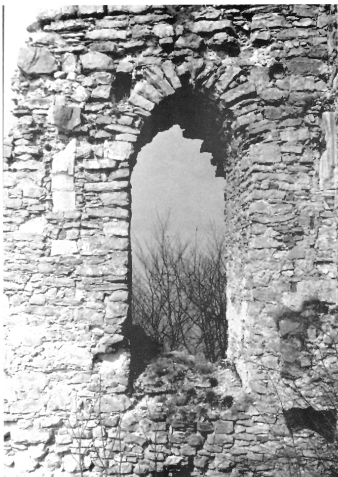
17. Unutrašnjost kapele, pogled na preostali prozor broda
