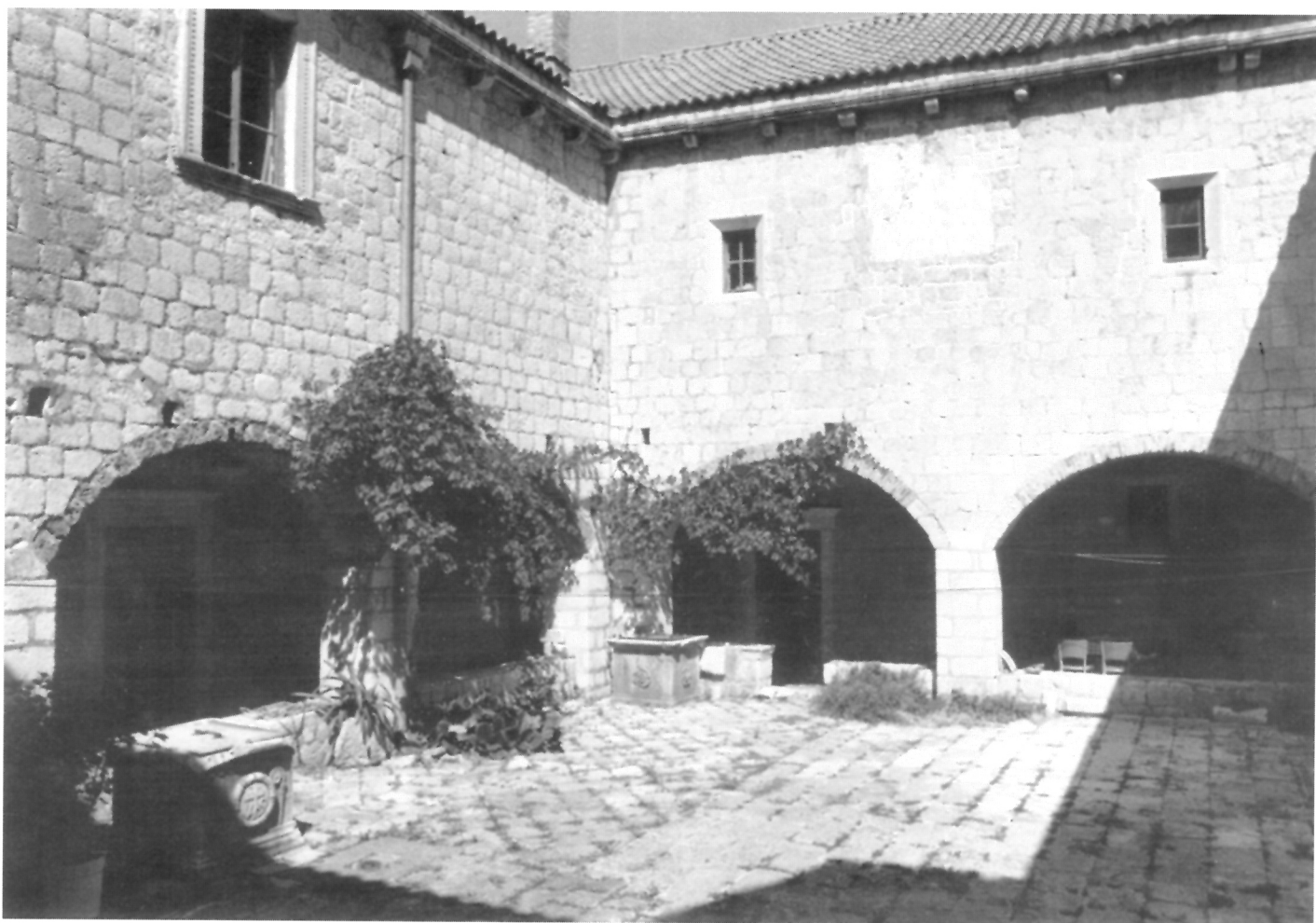
10. Klaustar, istočno pročelje s ostacima gotičkih otvora i sjeverno pročelje s renesansnim prozorom na mjestu starijeg otvora
