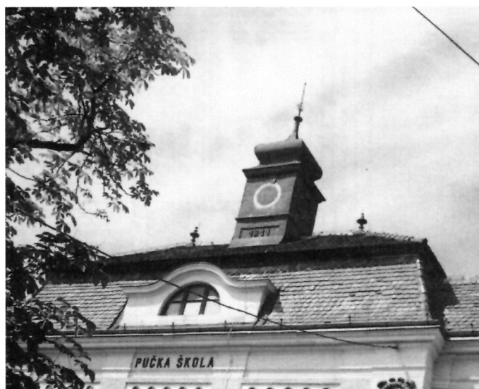
7a. Pročelje i začelje tornjića na kojem je trebao biti postavljen školski sat
